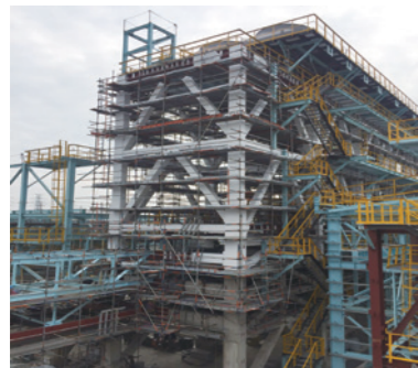
石油化工厂等的防火被覆（钢柱，钢梁等） / Fireproof cladding (steel column and steel beam, etc.) in petrochemical plant
