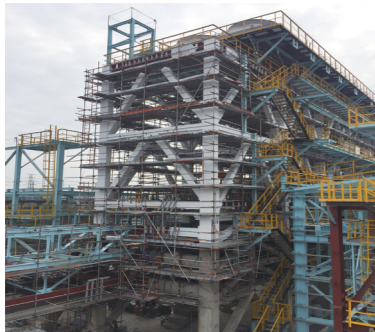
石油化工厂等的防火被覆（钢柱，钢梁等） / Fireproof cladding (steel column and steel beam, etc.) in petrochemical plant
